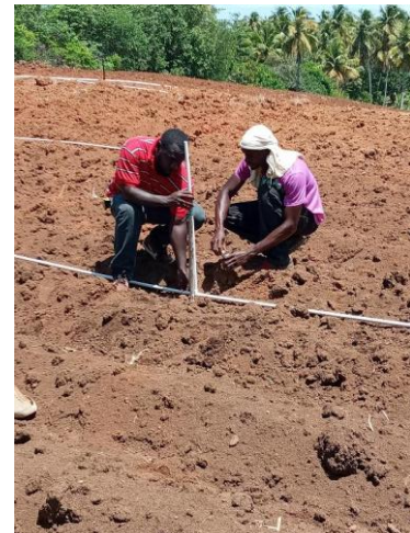
Formation d'un agriculteur à l'installation d'une ligne d'irrigation
