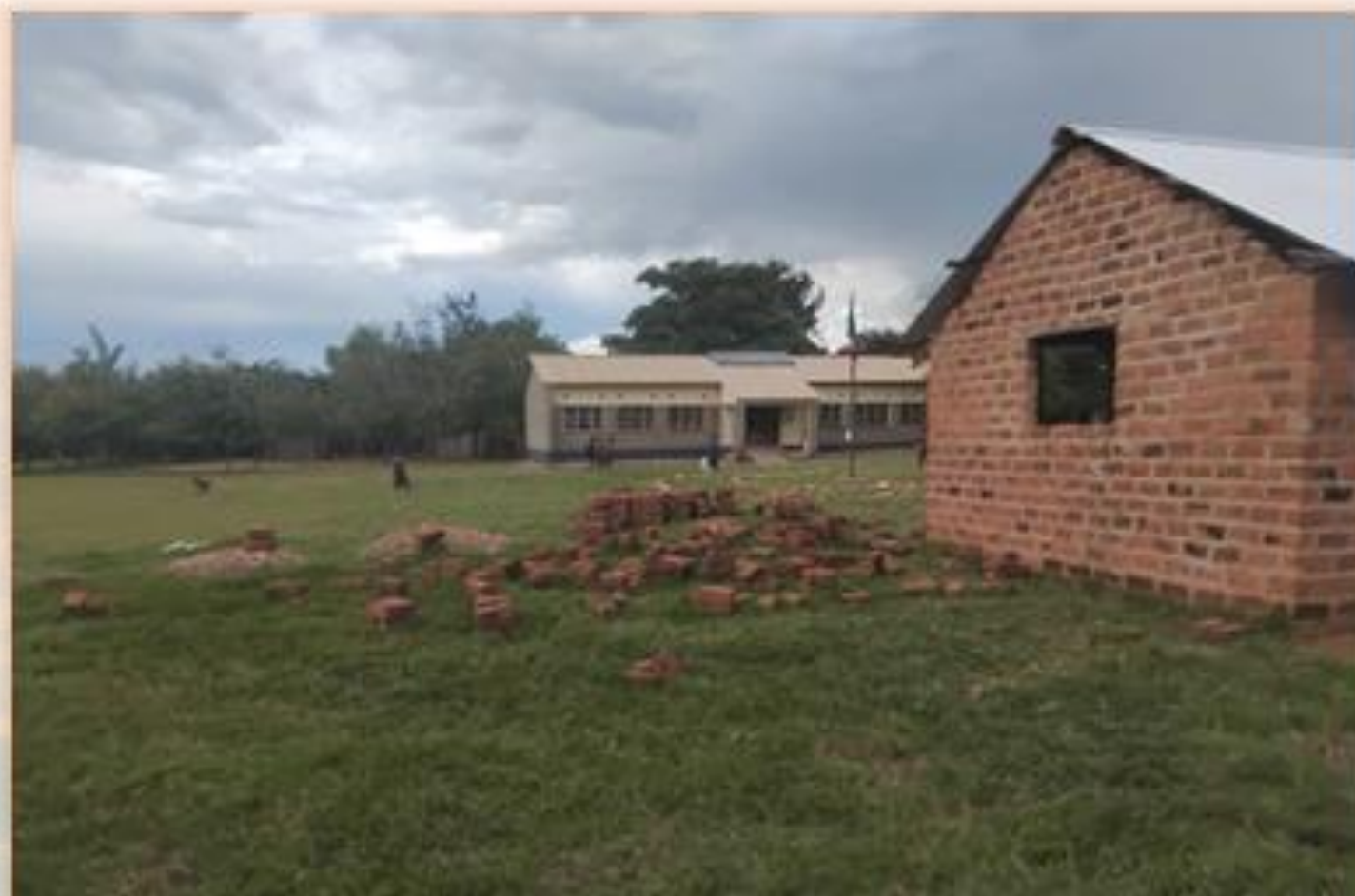
Les membres du Club Dimitra ont fourni des briques et ont notamment transporté les matériaux sur le site pour la construction d'une crèche communautaire.
